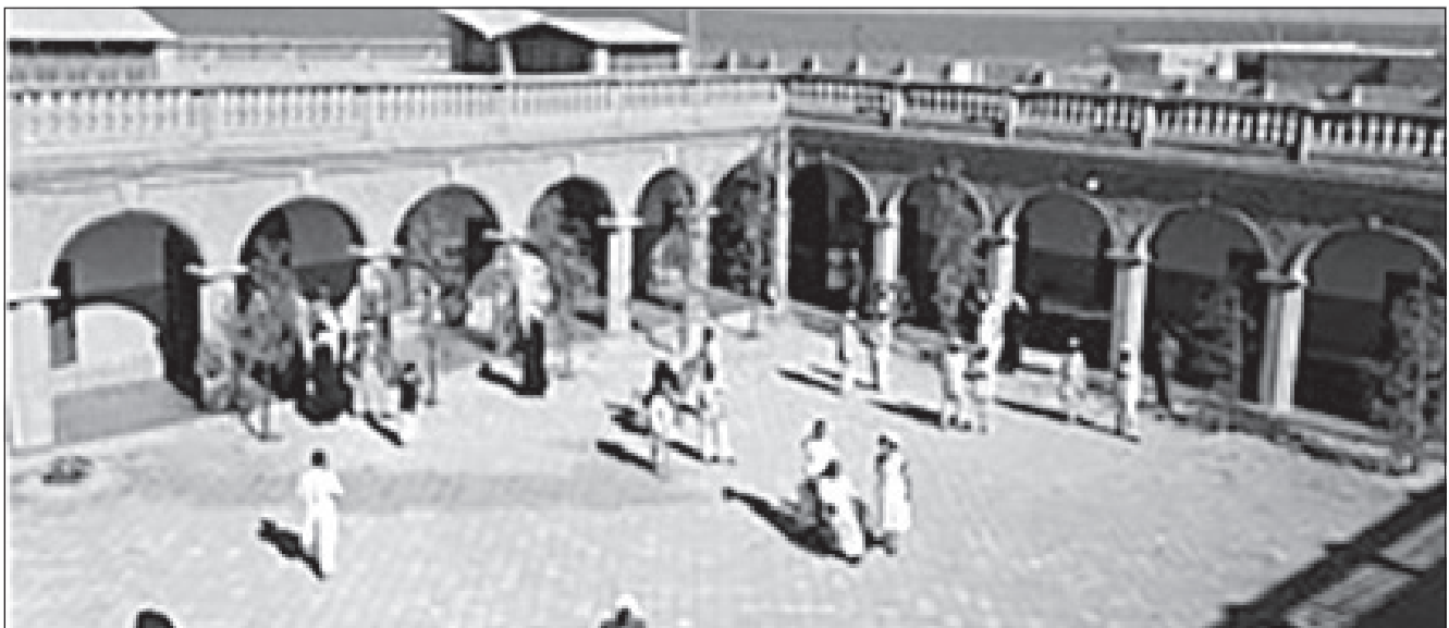
بناء المدرسة الأحمدية
